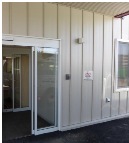
正面玄関 標識取付位置
